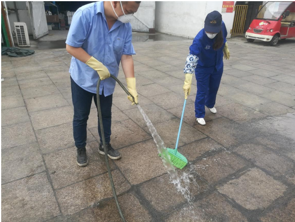
对地面残余危废用水冲洗
